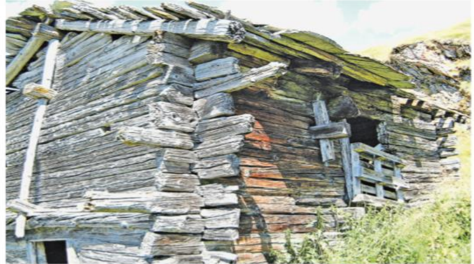
Umnutzen. Nicht mehr benötigte Stadel und Ställe ausserhalb der Bauzone sollen zu Wohnzwecken umgenutzt werden können – sofern dies in den kantonalen Richtplänen vorgesehen ist. FOTO WBS
